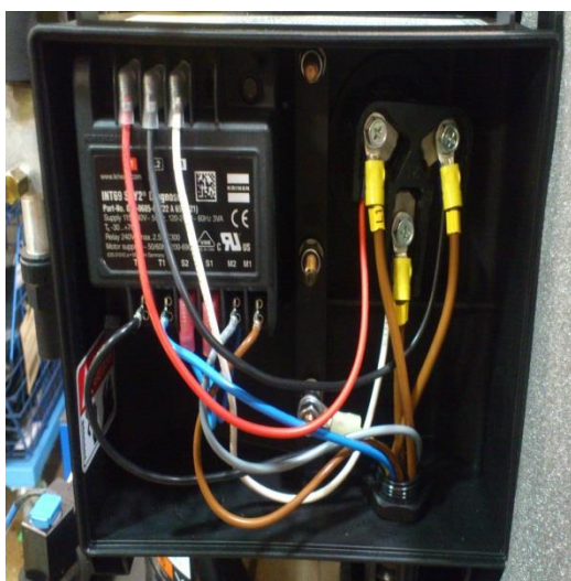
Рис. 13: Правильное подключение клеммной коробки IP54 с использованием кабельной муфты ZH146K1P
